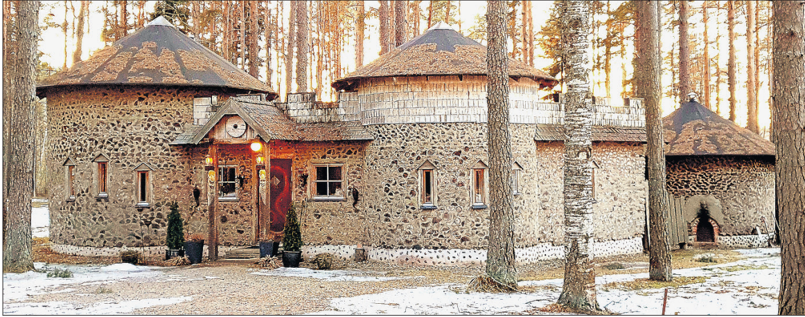
Humppilassa sijaitseva ViikinkiSauna muodostuu viiden saunan kokonaisuudesta. Alueelle on parhaillaan rakenteilla kuudes sauna.
